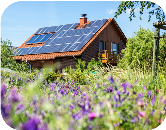
Wohngebäude (Ein- und Mehrfamilienhäuser)
