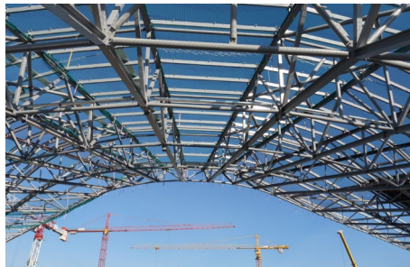
Stahl- und Leichtbaukonstruktionen
