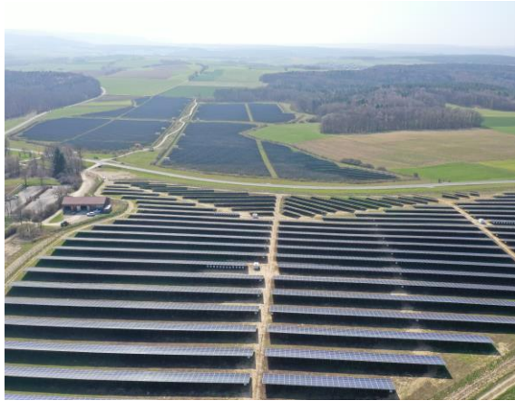
Gut Leimershof II; 96149 Breitengüßbach BJ 2019: Bauart Sungrow 125 WR Zentral am Trafo mit Gaks; 6,09 MWp
