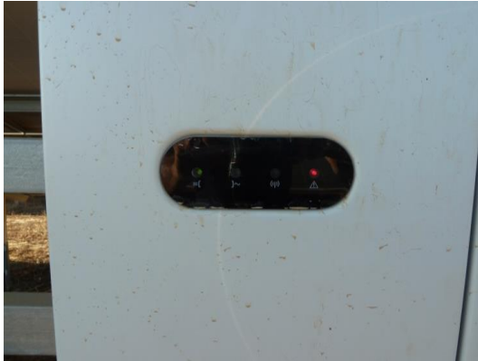
Wechselrichterausfall
