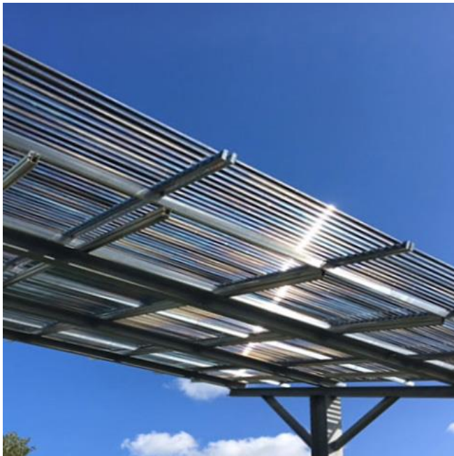
TubeSolar AG Versuchsanlage Weihenstephan (D)
