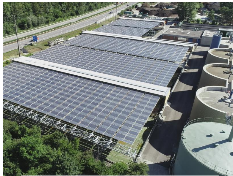
Überbauung Klärwerk; Chur (CH) DHP-Technology
