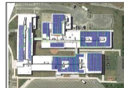
Überprüfung der Anlagenleistung
