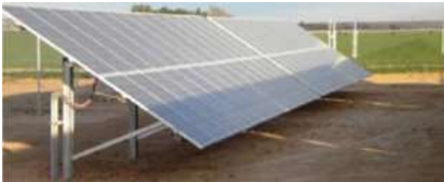
Beispiel für eine Verschattungssituation (Installation der Module in der Portrait Ausrichtung)
