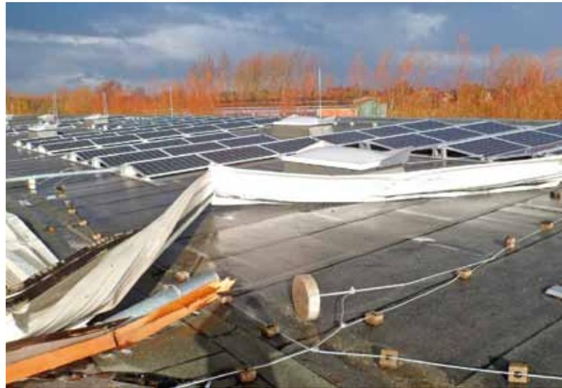
Eine Flachdachanlage nach dem Sturm Christian am 28. Oktober 2013. Der Dachbereich ohne Photovoltaikanlage wurde schwer beschädigt, wohingegen die Anlage selbst den Sturm unbeschadet überstanden und zudem weitere Dachflächen vor Schäden bewahrt hat. Das aerodynamisch optimierte System wird bei starkem Wind noch mehr an das Dach gepresst. Das macht das System stabiler, erhöht aber den Druck auf die Wärmedämmung. Die Kunst ist, beiden Anforderungen zu genügen.
