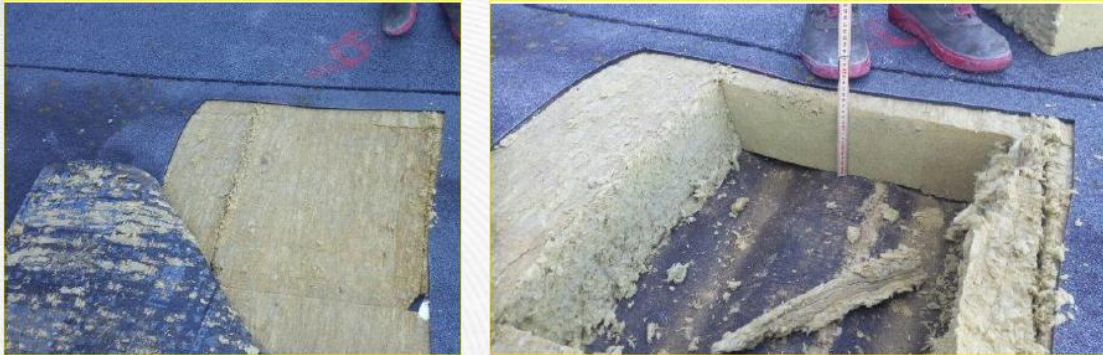
Probeöffnung bei einem Bitumendach mit Mineralwolldämmung
